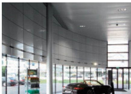
Innenansicht der geschwungenen Fassade. Verkleidung mit segmentierten Aluminiumblechen. Vue intérieure de la façade courbée. Habillage en tôles d'aluminium segmentées.
