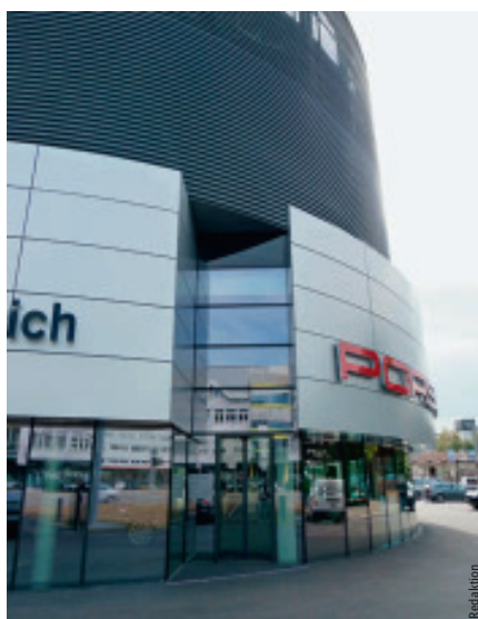
Der Haupteingang mit fortlaufender SSG-Fassade. Darüber hebt sich der helle, aus Alucobond-Platten gebaute Fassadenteil hervor.
