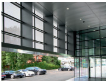
Seiteneingang zum Service-Empfang und zur Autoanalytik. Der perforierte Fassadenteil hängt an stabilen Schwertern aus 20-mm-Stahlblech an der Betondecke. Entrée latérale vers l'accueil pour les entretiens et les analyses de voitures. La partie de façade perforée est suspendue au plafond en béton par des autoportants stables en tôles d'acier de 20 mm.
