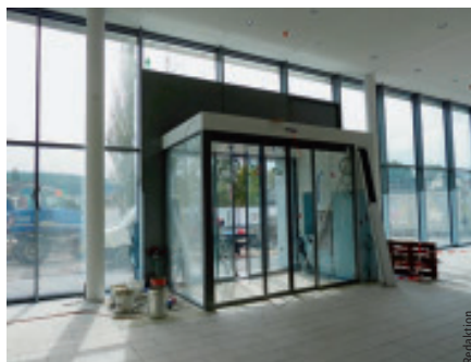
Der Kundeneingang zum VW Zentrum während der Bauphase. Die automatische Aussentüre in Kombination mit dem Windfang verhindert Wärmeverluste. L'entrée du centre VW destinée aux clients pendant la phase des travaux. La porte extérieure automatique donne sur un sas afin d'éviter les déperditions de chaleur.
