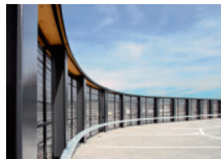
Die Fassade führt bis über die Dach-Park-Terrasse. Perforierte Aluminiumbleche sorgen für eine diskrete Transparenz.
