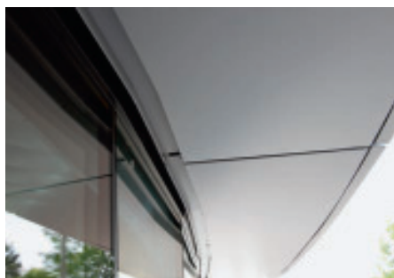
Untersicht ebenfalls aus Alucobond-Platten. Mit Übergang zur vertikalen Glasfassade. In der Ansicht sind keine Deckleisten zu erkennen.
