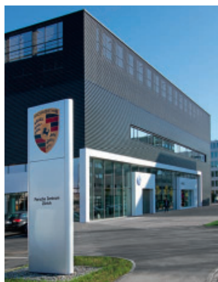
Der zweite Trakt – das VW Zentrum. Die Pfosten-Riegel-Front mit der weissen Blechzarge ist gegen die Goldschlängstrasse ausgerichtet. La deuxième aile : le centre VW. La façade en poteaux-traverses mise en valeur par un encadrement blanc donne sur la Goldschlängstrasse.
