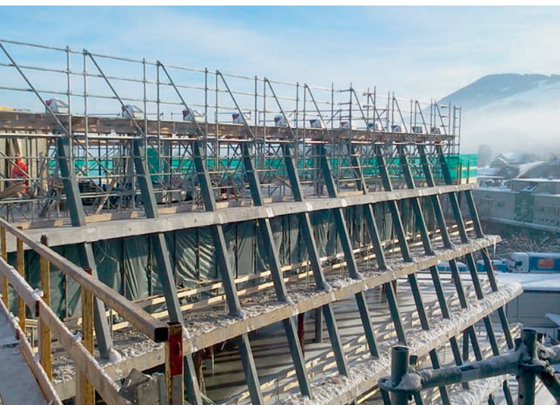
Winterliche Montagesituation. Gut zu erkennen die Stahlstützen des Skelettbaus. Progression du montage en hiver. Les supports acier de la structure sont bien visibles.
